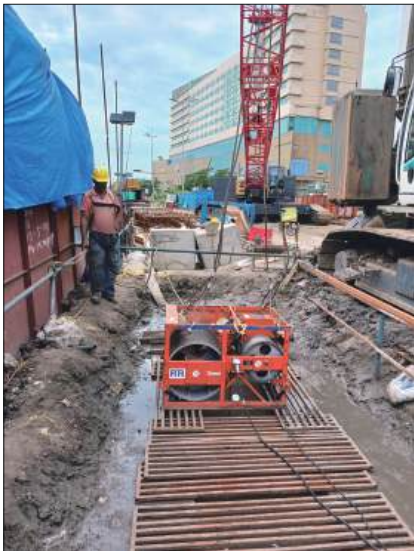
超音波側壁測定装置が現場で利用される様子
